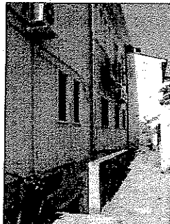
Particolare facciata nord
