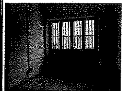
Locale a disposizione
